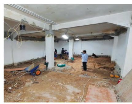
អតីតការិយាល័យត្រូវបានបំប្លែងទៅជានិហិតដ្ឋានបណ្ណាល័យទំនើបបំផុត។ រូបភាពទាំងនេះ បង្ហាញពីដំណើរការពង្រឹងគ្រឹះផ្ទាល់ដី។
